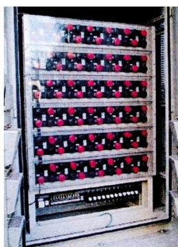
図-4 鉛電池システムの電池配列例
