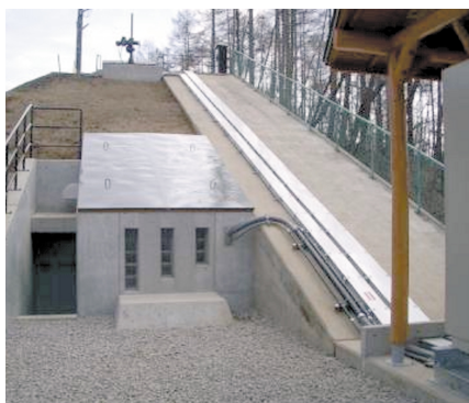
図-6 既設導水路の落差工を利用
