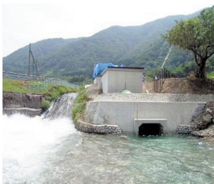
図-7 既設放水路の勾配を利用
