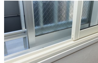
全住戸の内窓設置を実施
